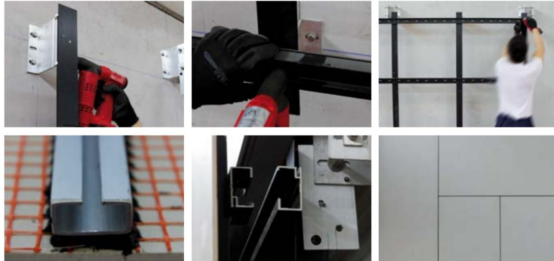
**DEFINITO IL PROGETTO ESECUTIVO DELLA FACCIATA, IL SISTEMA MAXI LIGHT, CHE RICHIEDE RISPETTO A MAXI FRAME LA POSA DI UN RETICOLO DI FACCIATA, CONSENTE DI INIZIARE LE OPERAZIONI EFFETTIVE DI MONTAGGIO IN CANTIERE CONTEMPORANEAMENTE ALLA PREPARAZIONE DEI MANUFATTI IN STABILIMENTO.**
