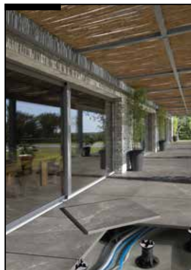
POSA SOPRAELEVATA E DRENANTE pag. 104
