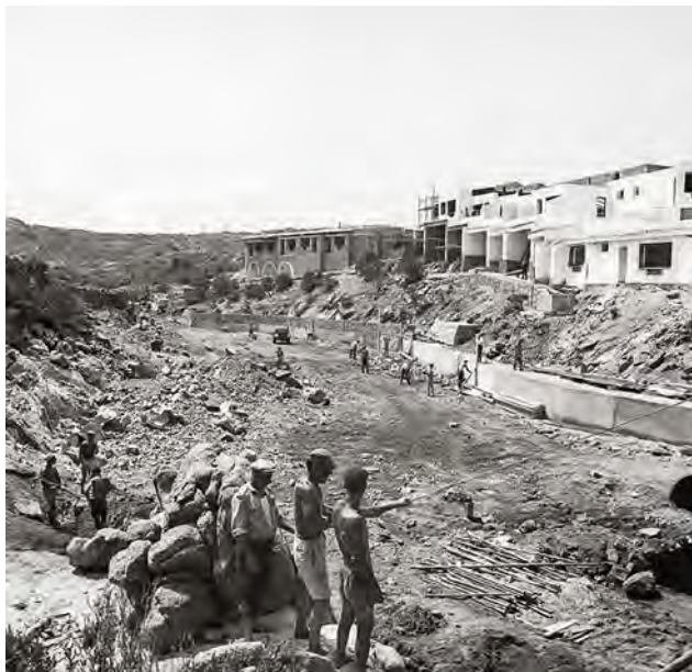
Fase iniziale dei lavori di costruzione nella Costa Smeralda, in Sardegna, probabilmente risalente agli anni '60.
