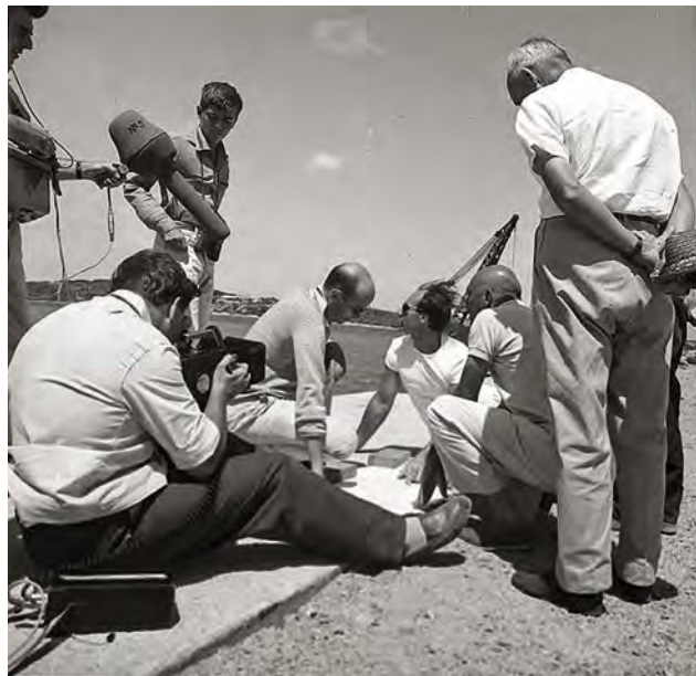
Aga Khan, Costa Smeralda, Porto Cervo in costruzione, 1964
